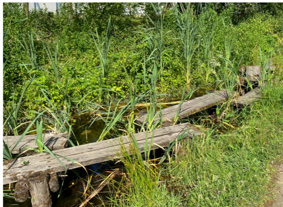
10-Verhoogde plankier (bestaand)
