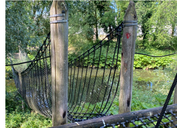
8-Touwbrug Superspeelspoor (bestaand)
