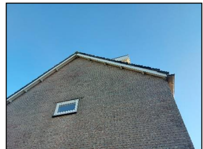
Figuur 8. Kopgevel van woning ten oosten van de onderzoekslocatie.
