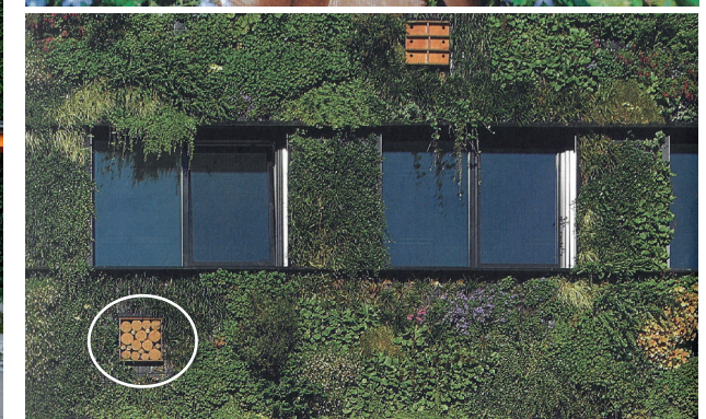
Natuurinclusief ontwerpen: nestkastje geïntegreerd in de groengevel. Aeres Hogeschool, Almere
