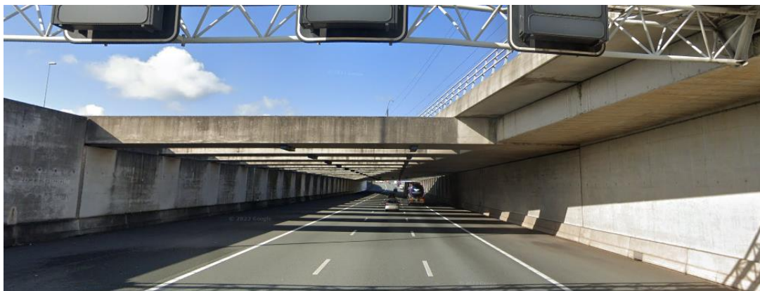
Figuur 25. Voorbeeld van een pergolaconstructie (kruising A4 – HSL) (bron: Google street view)
