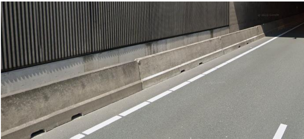
Figuur 12. Voorbeeld van een halve stepbarrier (A2 Leidse Rijn) (bron: Google street view)
