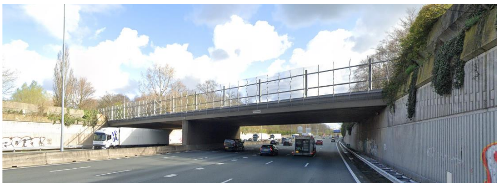
Figuur 23. Viaduct Koningsweg (bron: Google street view)
