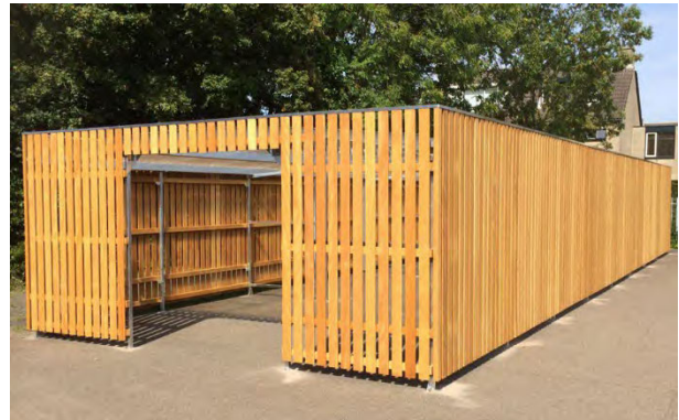
Fietsenstalling met houten schotten
