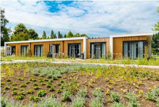
Breda (één bouwlaag)
