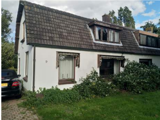
Voorzijde bebouwing in plangebied.
