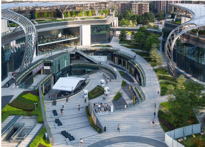
Voetgangersbruggen markeren de verbindingen
