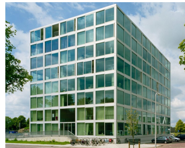
Alzijdig gebouw met een transparante plint
