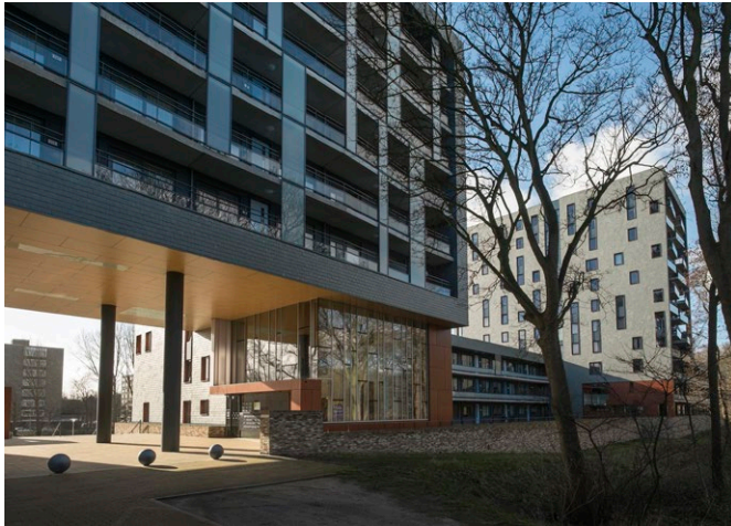
Opgetild volume t.b.v. onderdoorgang
