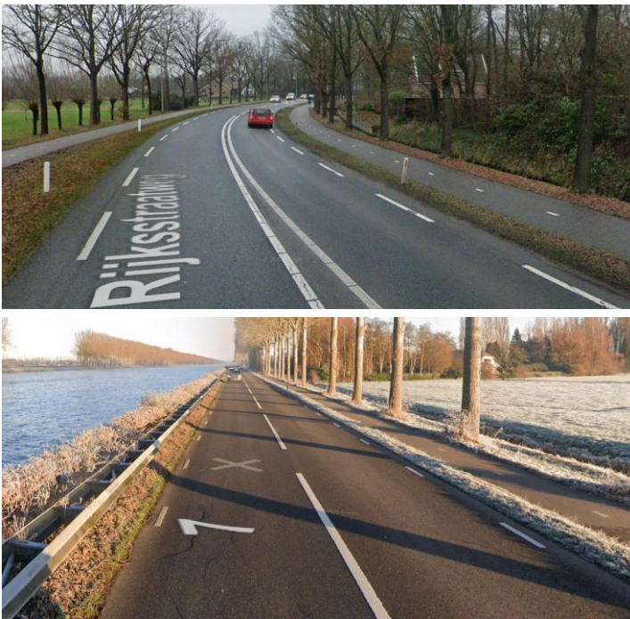
Figuur 5: Boven, de inrichting van de N402 richting het noorden. Onder, de Oostkanaaldijk ten noorden van het kruispunt met de Slootdijk.
