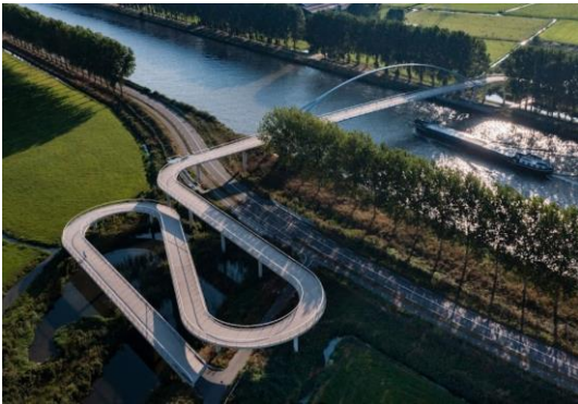
Figuur 6: De voetgangers- en fietsbrug te Nigtevecht
