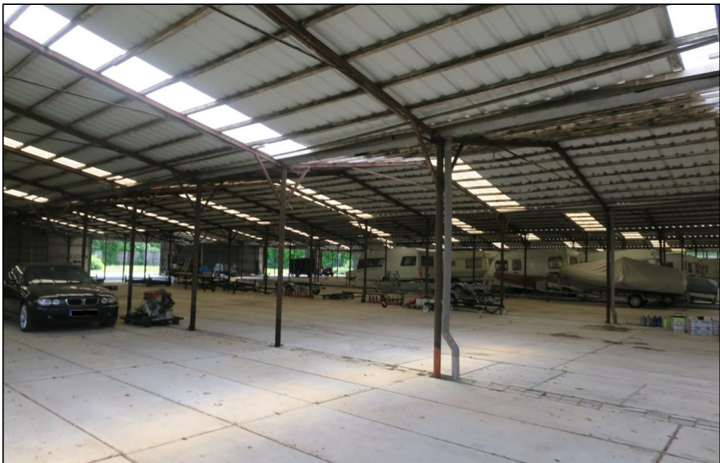
Figuur 4 De binnenzijde van het te slopen bedrijfsgebouw.
