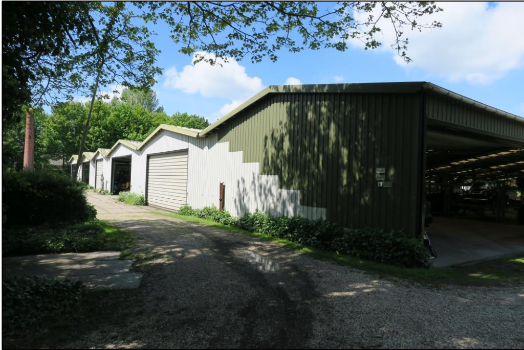
Figuur 2 Fotografische indruk van het te verwijderen bedrijfsgebouw. Links in dit figuur is de historische schoorsteen weergegeven. Deze blijft behouden.
