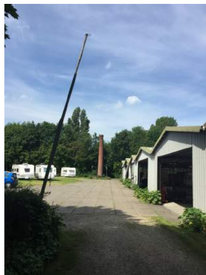
De schoorsteen van de voormalige kasverwarming nabij de zuidwesthoek van de caravanstalling. Foto SIA, 22 mei 2017
