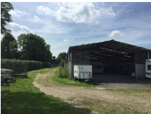
Zicht op de noord- en oostzijde van de caravanstalling met het rijpad langs de oostzijde. Foto SIA, 22 mei 2017
