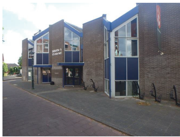
Foto 06: gevelpanelen buitenzijde Trespa - Niet asbestverdacht
