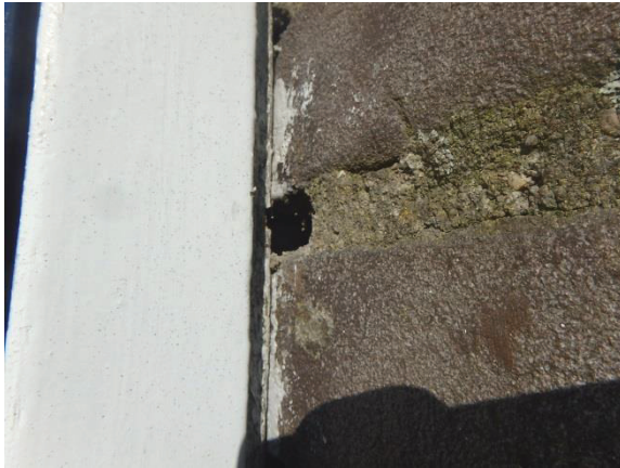
Foto 07: in de spouw – Geen asbestverdacht materiaal aangetroffen
