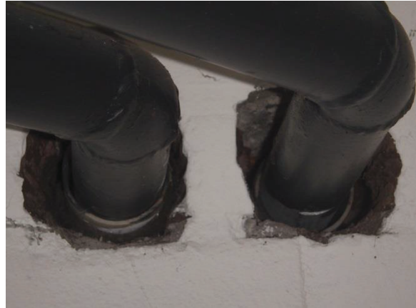
Foto 08: in de doorvoeren – Geen asbestverdacht materiaal aangetroffen
