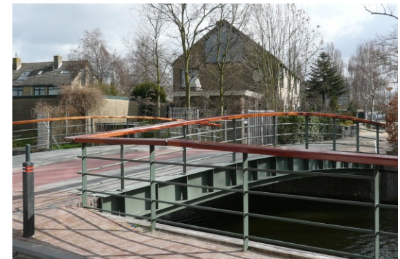
Stalen brug geschikt voor autoverkeer
