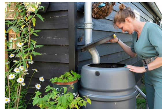
Regenton met hemelwaterafvoer
