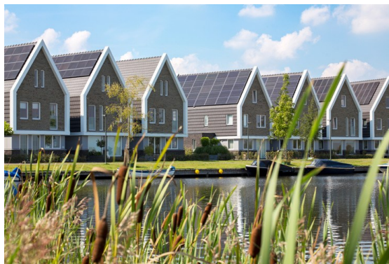
Zorgvuldige plaatsing van zonnepanelen
