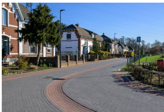
Karrensporen met centrale molgoot
