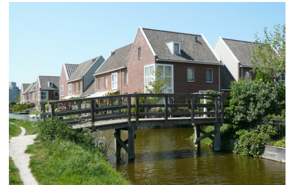
Houten brug met doorlopende oevers
