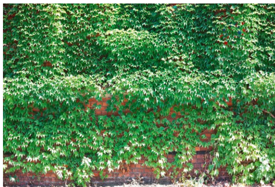
Vergroende bakstenen muur
