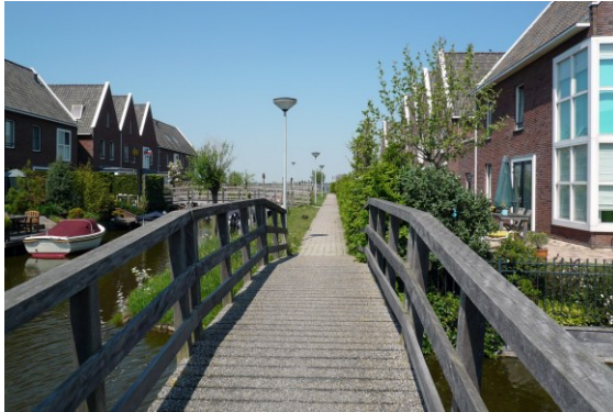
Houten brug voor langzaam verkeer
