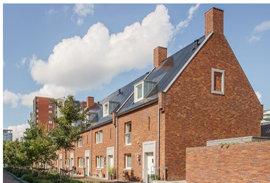
Inpassing dakkapel tussen zonnepanelen
