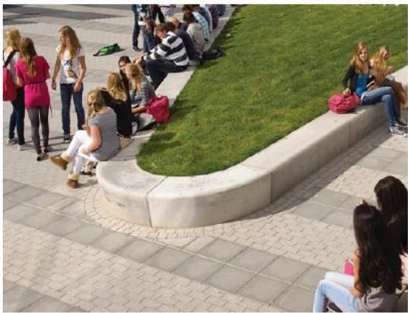
Groenbakken met betonnen (zit)rand
