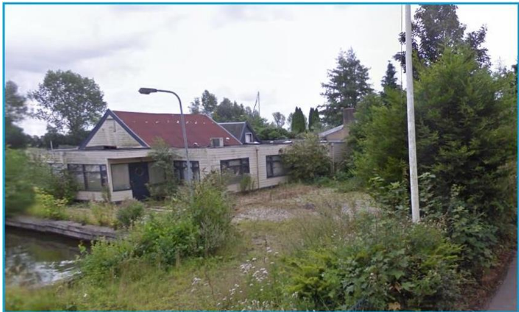
Figuur: leegstaande bedrijfspand Vreelandseweg 11 (Bron: Google Streetview).
