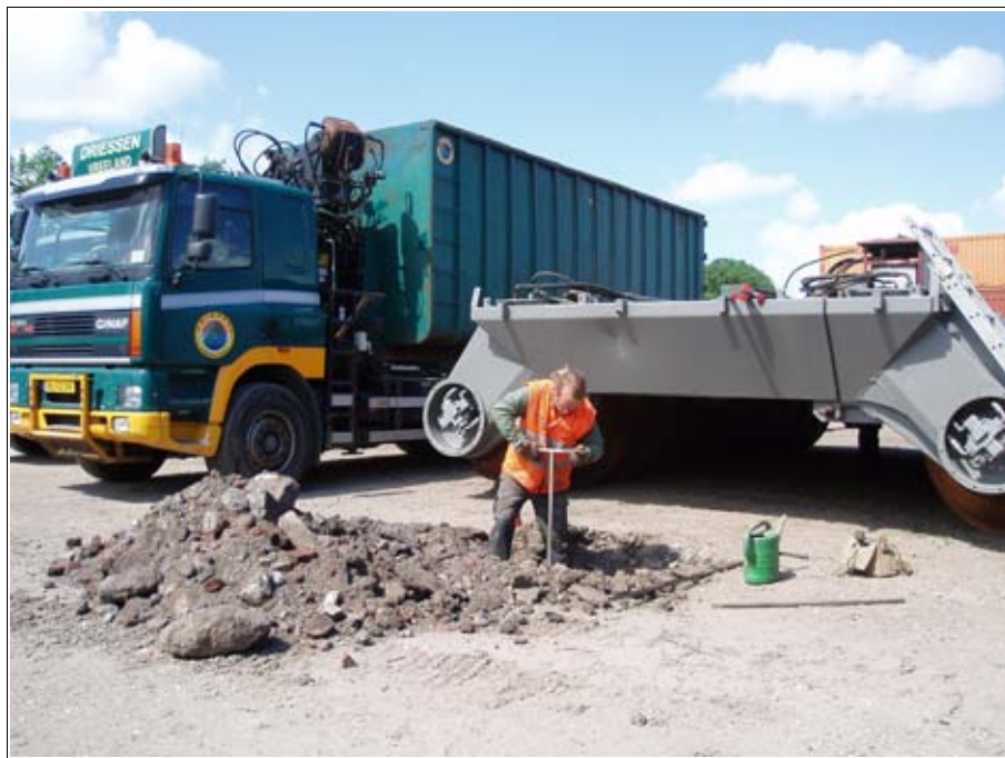
Figuur 7: Vreeland, Kleizuwe 105A: op de foto wordt boring 30 uitgevoerd. Voor de boring is door een graafmachine het puindek verwijderd.
