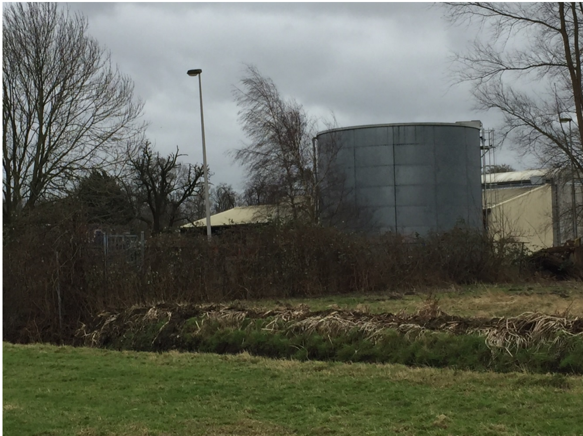
Afbeelding 11: Zicht op het bestaande bedrijventerrein vanaf de locatie van de jachthaven. Foto januari 2016.
