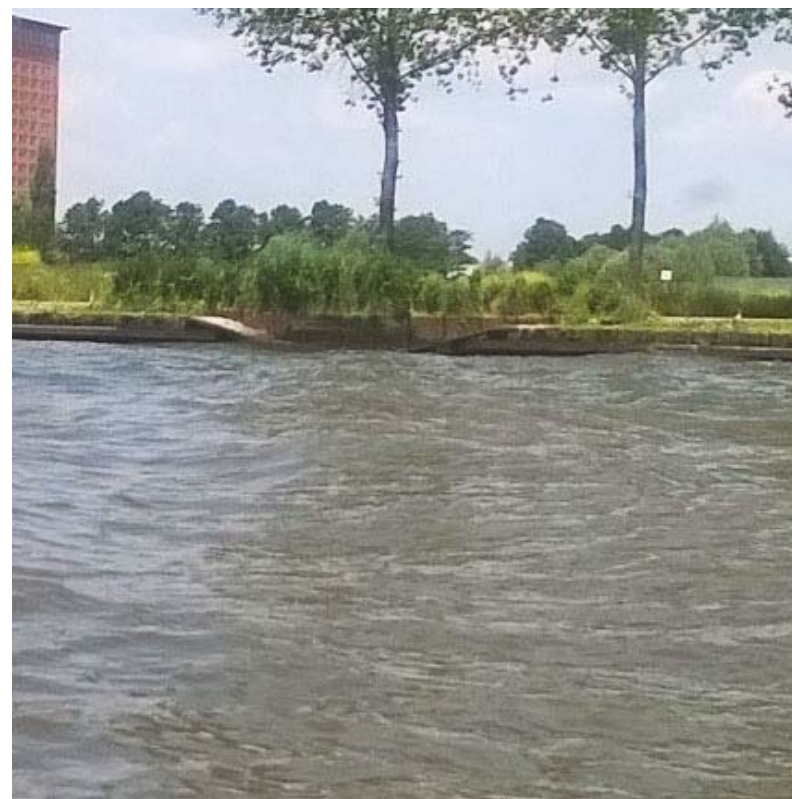
REFERENTIEBEELD VAN EEN FUP IN HET AMSTERDAM-RIJNKANAAL NABIJ HOUTEN
