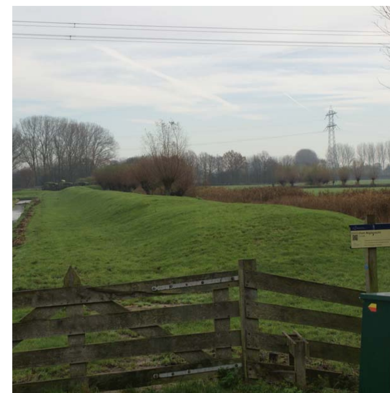
15. LINIEDIJK MET NEVENBATERIJEN EN DAARACHTER FORT BIJ NIGTEVECHT
