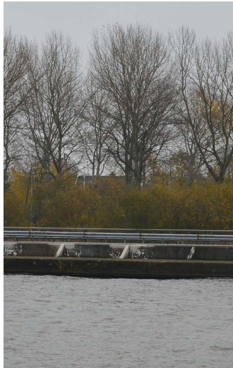
14. WATERINLAAT OOST-KANAALDIJK TEN BEHOEVE VAN INUNDATIE
