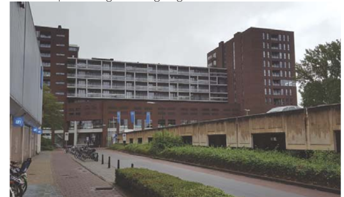
P1 en MAR'CS gebouw
