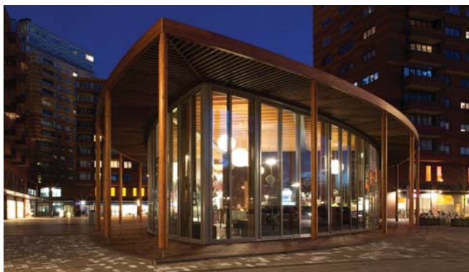
Paviljoen Waterlandplein Amsterdam, architect Emiel Lamers
