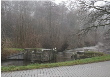
Sluis in het kanaal bij Fort Tienhoven.
