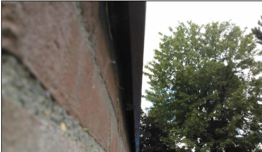
Figuur 4.4.1: Voor vleermuizen toegankelijke ruimte achter houten gevelbetimmering van het restaurant.
