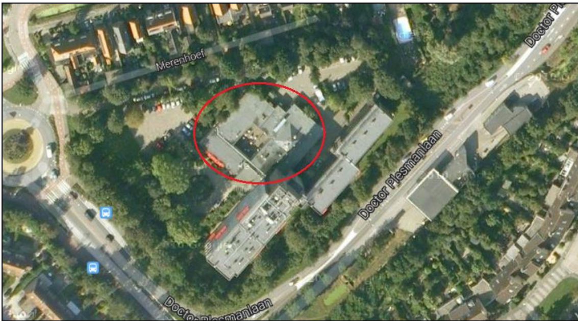
Figuur 1: Te slopen restaurant met voor vleermuizen geschikte gevelbetimmering (rood omlijnd).
