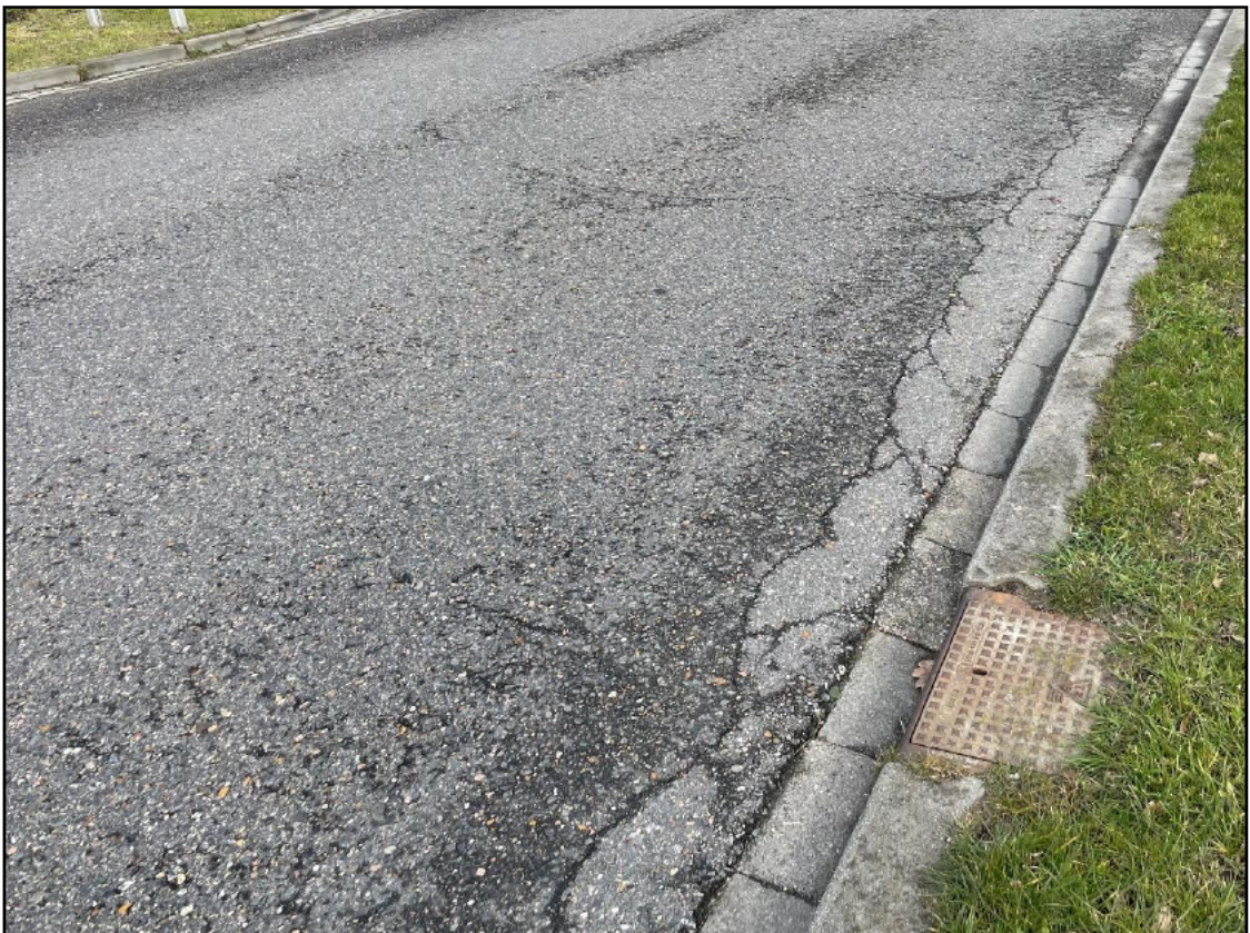
Figuur 5 Geconstateerde matige randschades in vak 2
