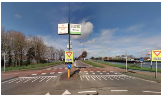
Rotonde Brugoprit Stationsweg heeft fietsers in voorrang in 2 richtingen. Verkeer vanuit Breukelen en achterland zal dit punt kruisen. De inrichting is duidelijk vormgegeven. In spitsperiodes ontstaat terugslag van het verkeer doordat zij fietsers voorrang dienen te verlenen.
