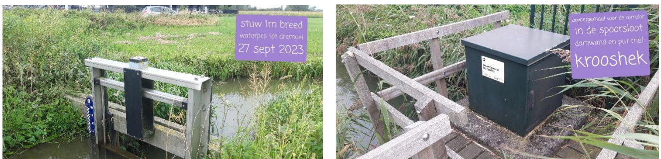
Figuur 2.3: Stuw (links) en opvoergemaal (rechts) voor de Corridor in de spoorstoot.
