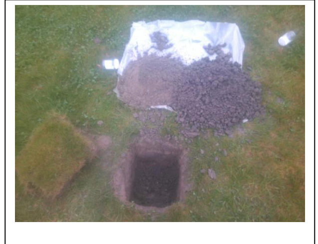
Foto 2. Asbestinspectiegat B02
