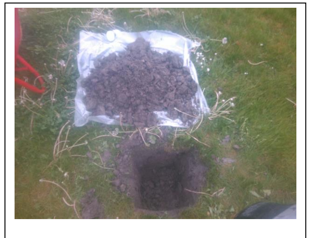
Foto 7. Asbestinspectiegat B07
